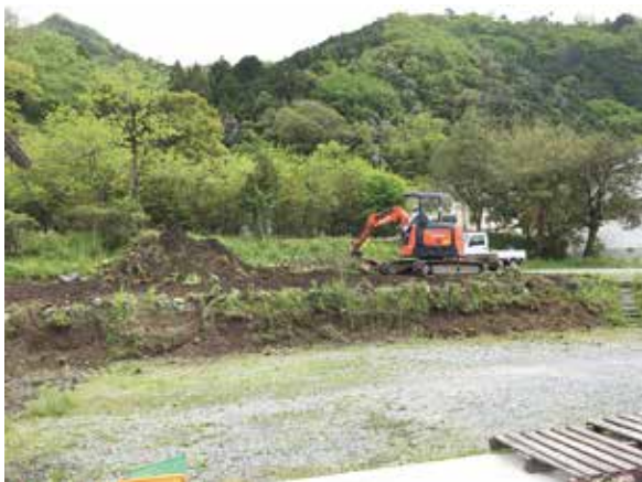
下：裏の畑の土砂撤去作業工事 2018年4月
