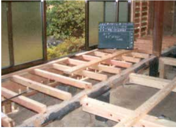
改修中の「唯称寺」 平田工務店に施工を依頼
